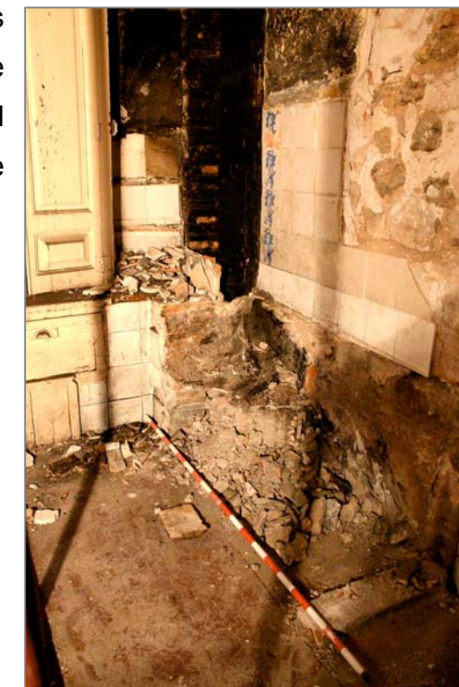
Dues vistes de les feines de desmuntatge i aterrament del moble d'obra de la cuina i de l'envà que cobria la paret mitgera
