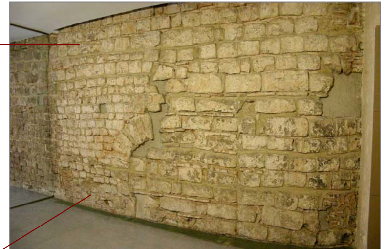
Vista general del parament corresponent al segon pis de la torre romana a la seva cara més septentrional. Podem observar els testimonis de l'"opus vittatum" i part d'una de les finestres que s'obria en direcció a l'interior de la ciutat
