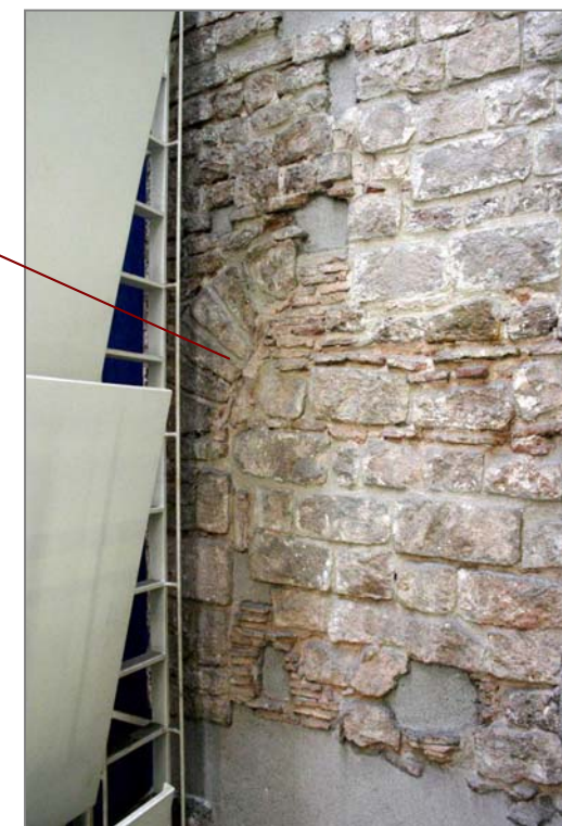
Detall dels testimonis de la finestra de segon pis de la cara oriental de la torre romana baix imperial visible des del Pati Llimona
