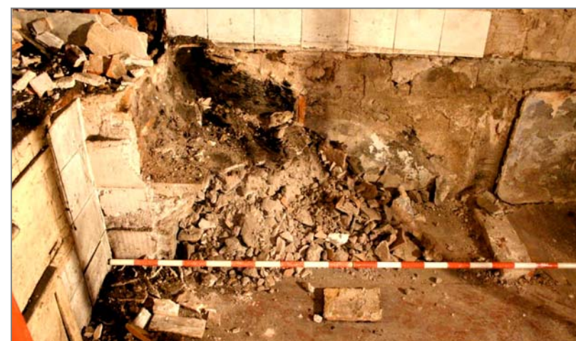
Dues vistes de les feines de desmuntatge i aterrament del moble d'obra de la cuina i de l'envà que cobria la paret mitgera
