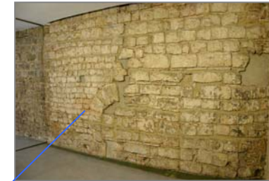
Cara septentrional de la torre romana en el seu segon nivell. Pati Llimona
