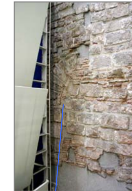
Cara oriental de la torre romana amb el testimoni de la finestra del segon pis i la remunta baixa medieval
