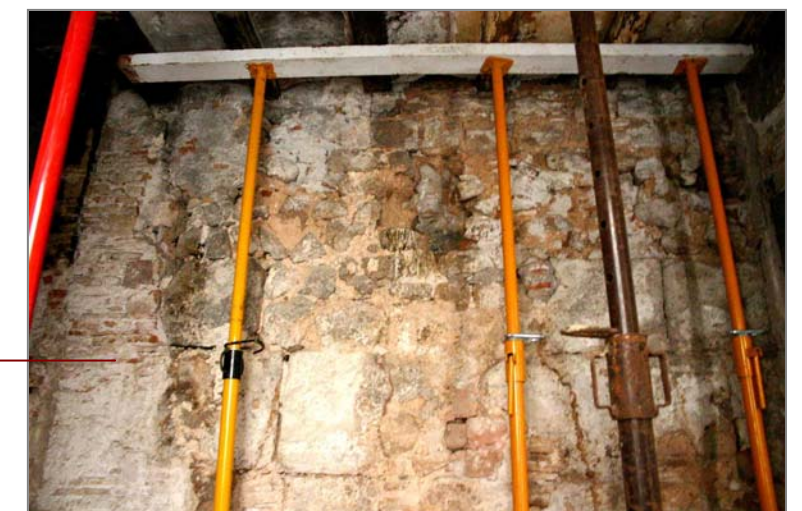
Vista parcial de la zona d'entrega de la torre amb el pany de muralla (vegeu els maons) a l'alçada del pis principal de Regomir
