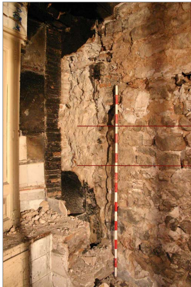
Vista general i localització en planta de la secció del segon pis de la torre romana del portal de Regomir descoberta en la mitgera de la cuina del primer pis de l'edifici.
